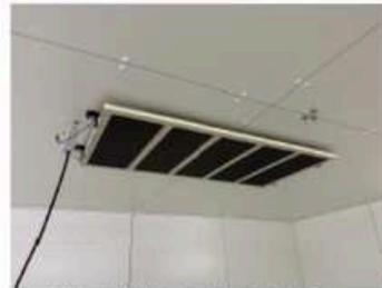
Abbildung 2: Montage des Heizgerätes an der Decke
